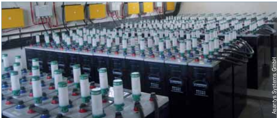
Größte Off-Grid-Solaranlage weltweit: HOPPECKE OPzS solar.power im Einsatz.
