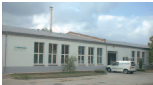
Site de production de HOPPECKE Technologies à Zwickau (Allemagne)
