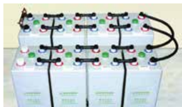
Fig. 5-15: Impiego di connettori in serie e per gradini
