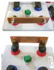
Fig. 5-17: 2 esempi per il montaggio dei poli terminali (piastre di connessione)
