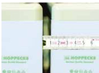
Fig. 5-14: Distanza di 10 mm tra gli elementi batteria
