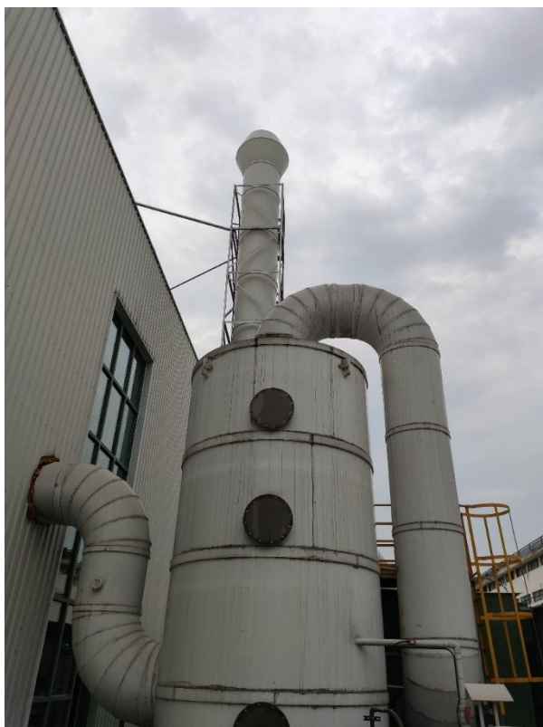
图 4-4 硫酸雾喷淋净化装置
