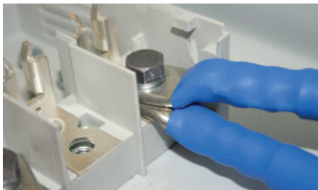
Abbildung 8: Paralleler Anschluss sun.fusebox NH00
