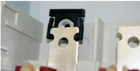
Abbildung 9: Fixierung der Mutter
