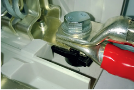
Abbildung 11: Paralleler Anschluss sun.fusebox Bauart NH2
