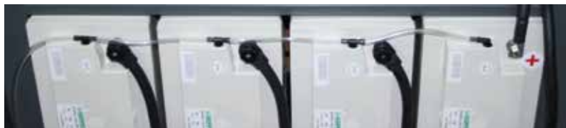
Immagine 6: Esempio sistema di degassificazione centrale
