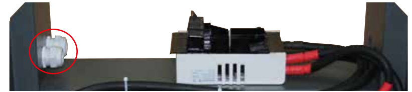
Afbeelding 8: Bovenste vlak van de drager met kabelschroefverbindingen
