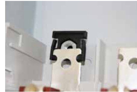
Imagen 2: Fijación de la tuerca debajo del borne plano
