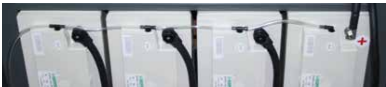
Illustration 6: Exemple de dégazage centralisé
