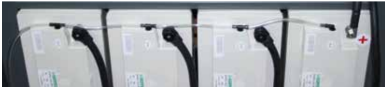
Abbildung 6: Beispiel Zentralentgasung
